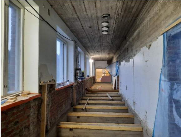
Härmälän koulun perusparannuksen työmaa, välipohjatäytön imu-/siivoustyö
