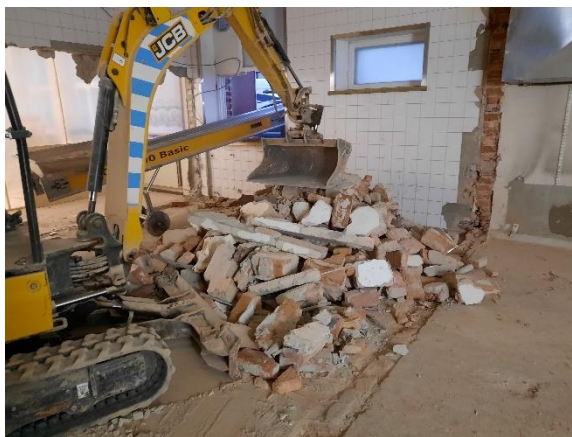
Härmälän koulun perusparannuksen työmaa, betoni-/tiilijätteen siivoustyö
