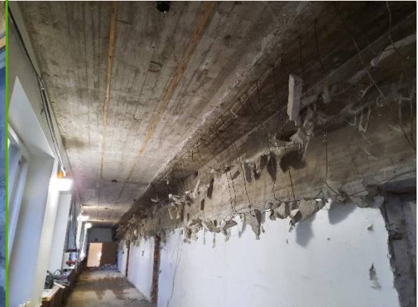
Härmälän koulun perusparannuksen työmaa, betonipalkin purkutyö
